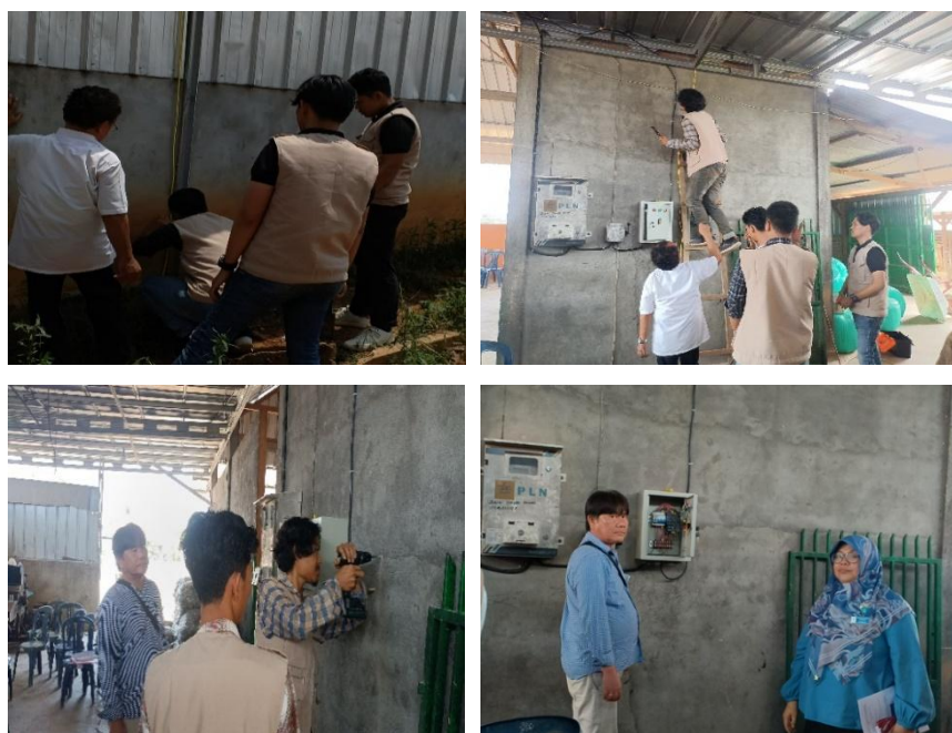
Gambar 7. Pelaksanaan Kegiatan : Pemasangan grounding oleh mahasiswa (kiri atas), Pemasangan down konduktor (kanan atas), Pemasangan panel untuk penempatan SPDs (kiri bawah), Dosen peserta PKM didepan panel SPDs (kanan bawah)
